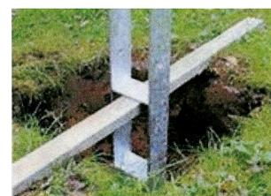
Pour maintenir les ancrs en place, placez des pavés ou autre calage) à gauche et à droite du trou d'ancrage et passez un tasseau dans l'ancrage. Toutes les ancrs sont ainsi au même niveau au-dessus du sol et ne peuvent ni s'enfoncer, ni bouger dans le béton encore humide. Vérifiez bien l'aplomb des ancrs.
