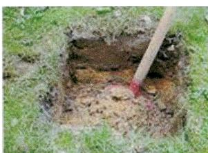
Pour obtenir une pente suffisante pour l'évacuation de l'eau, il est nécessaire de réduire la longueur des poteaux successivement de 3 et 5 cm.
